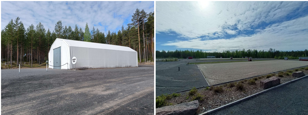
Ravintolatoiminnassa oleva pressuhalli (vas.) ja hevosurheiluun liittyviä rakenteita, ratsastuskenttää yms. (oik.). Alueella järjestetään esimerkiksi hevostapahtumia ja -kilpailuja.
